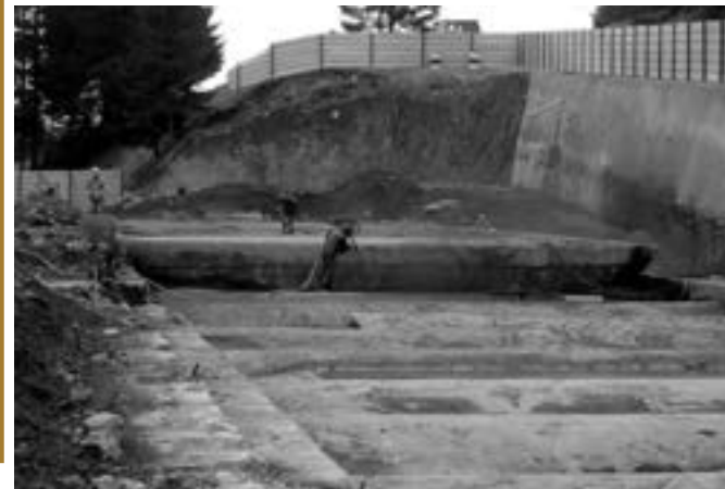
Mises à nu des caves, pendant le projet. © Agence Faloci
