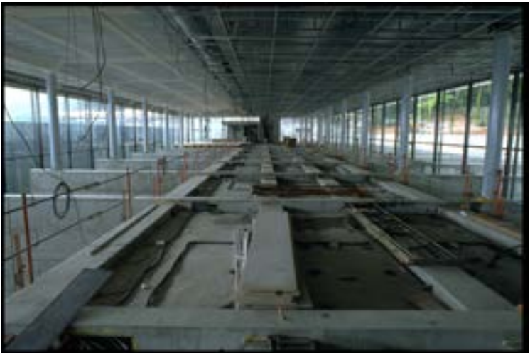
Chantier de construction, exposition permanente, 1993. © Bibracte, Antoine Maillier / n°118476
