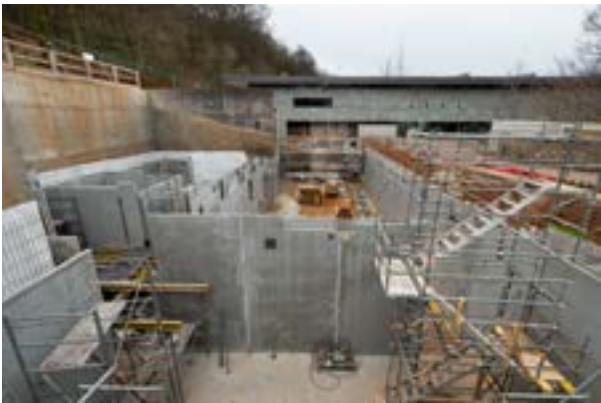
Chantier d'extension du musée, creusement de la cour de service. © Bibacte, Antoine Maillier 2023 / n°140111
