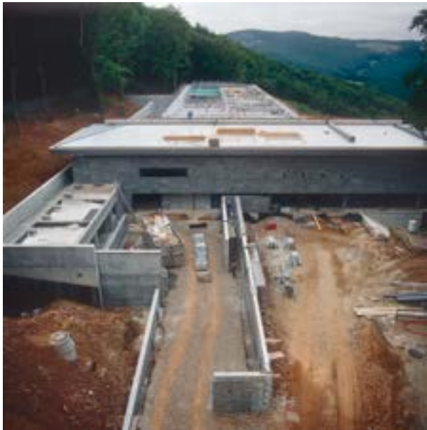
Début du chantier d'extension du musée, en 2022. © Bibacte, Antoine Maillier 2022 / n°1042403
