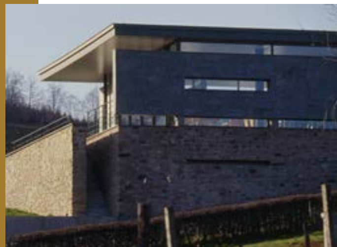
Superposition de matériaux en façade du restaurant du centre de recherche, Glux-en-Glenne.
