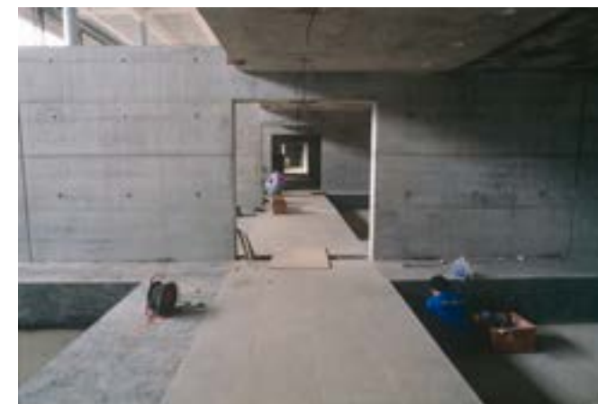
Voiles de béton qui structurent le parcours de la galerie inférieure de l'exposition permanente et ménagent cadrages et perspectives, 1994. © Bibracte, Antoine Maillier 1994 / n°102582
