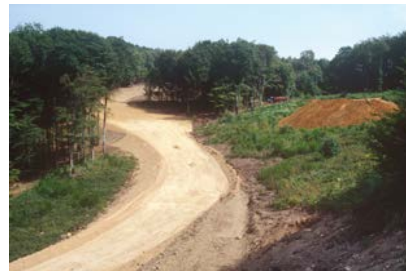
Travaux de déplacement de la route départementale, au moment de la construction du musée, 1992. © Bibracte, Antoine Maillier 1992 / n°102729
