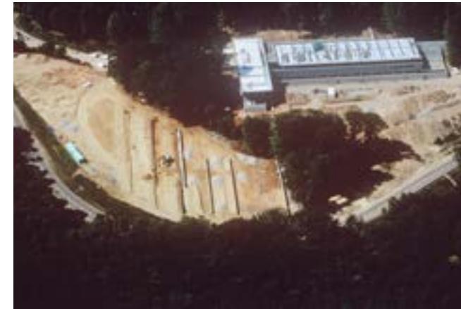
Chantier de construction du musée et de création de la trame de murs du parking paysager, juillet 1994. © René Goguey, Recherches d'archéologie aérienne
