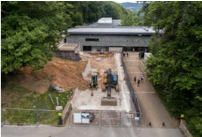
Chantier de construction du musée de Bibacte, en 1994. © Bibacte, Antoine Maillier 1994 / n°107954
