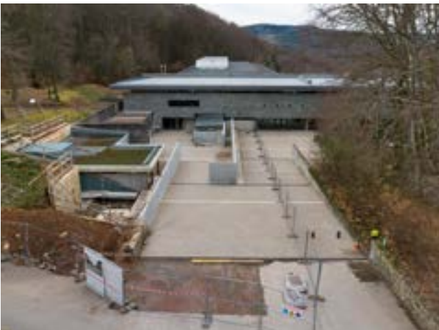
Dernières opérations du chantier pour créer les nouveaux espaces d'exposition, 2023. © Bibacte, Antoine Maillier 2024 / n°142484
