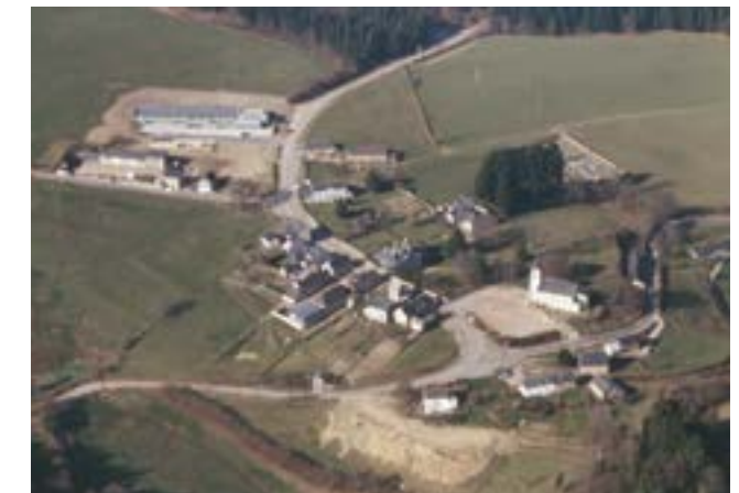
Vue aérienne du village de Glux-en-Glenne, à la fin du chantier de construction du centre de recherche et de la cafétéria, en 1995. © Bibracte, Antoine Maillier 1995 / n°102616
