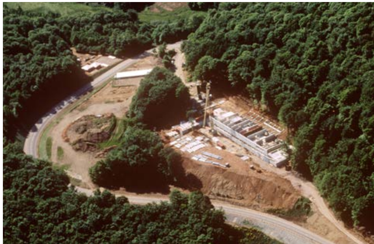
Chantier de construction du musée, mai 1993. © René Goguey, Recherches d'archéologie aérienne
