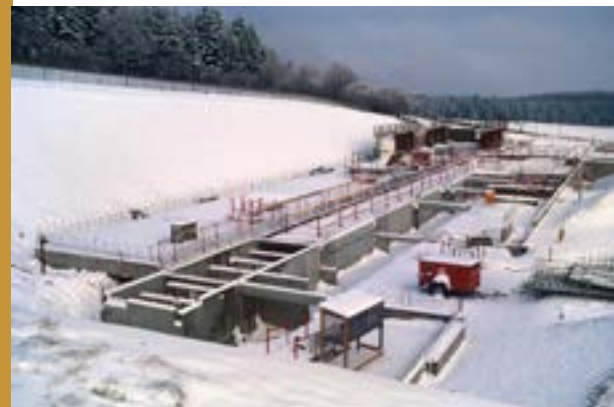
Chantier de construction du Centre archéologique européen. © Bibracte, Antoine Maillier 1994 / n°102668
