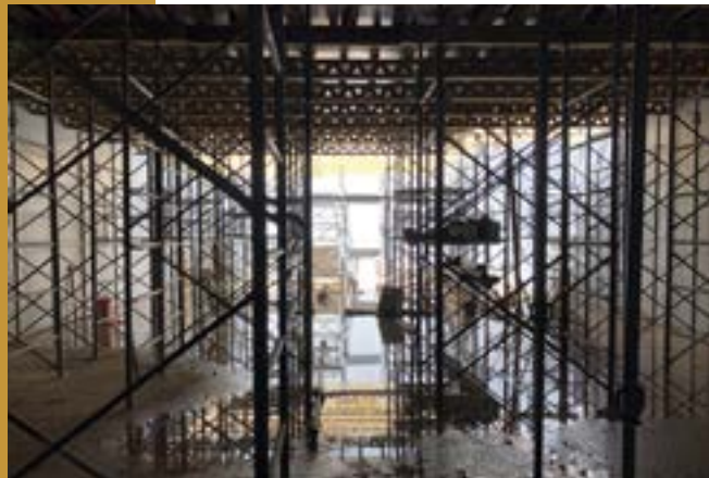
Chantier d'extension du musée de Bibracte, nouvelle salle d'exposition, 2022-2023. © Agence Faloci
