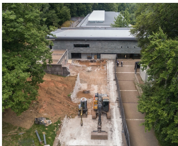
Début du chantier d'extension du musée, en 2022 © Bibracte, Antoine Maillier 2022
