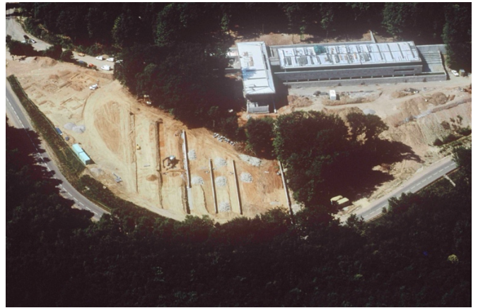
Chantier de construction du musée, juillet 1994. © René Goguey, Recherches d'archéologie aérienne
