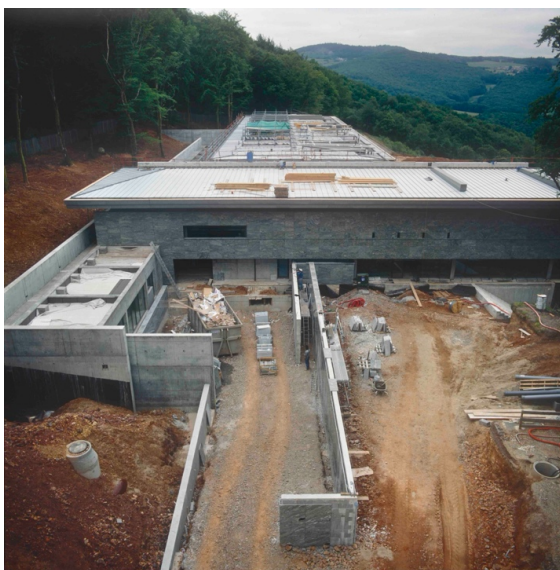
Chantier de construction du musée de Bibracte, en 1994. © Bibracte, Antoine Maillier 1994
