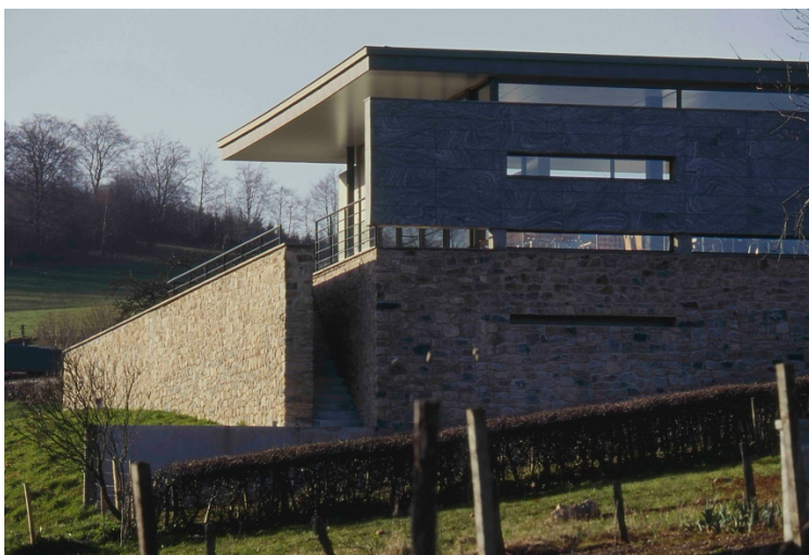
Superposition de matériaux en façade de la cafétéria, Glux-en-Glenne. © Daniel Osso
