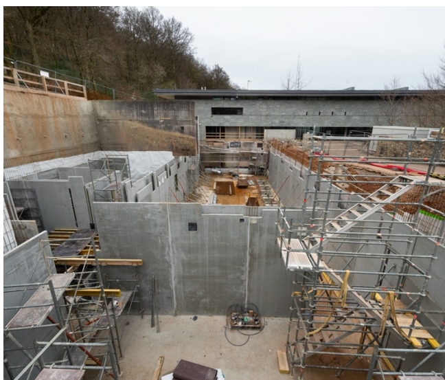
Chantier d'extension du musée, creusement de la cour de service pour créer les nouveaux espaces d'exposition, 2023. © Bibracte, Antoine Maillier
