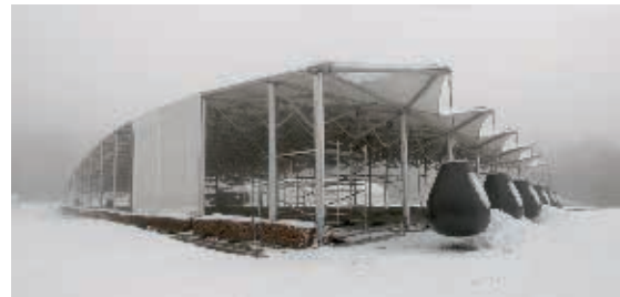
8. L'abri de protection des vestiges de la Pâture du Couvent conçu par Paul Andreu. Cliché Bibracte/A. Maillier, n° 74703
